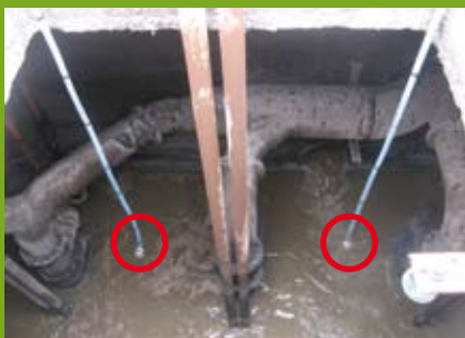
Poste de relevage
