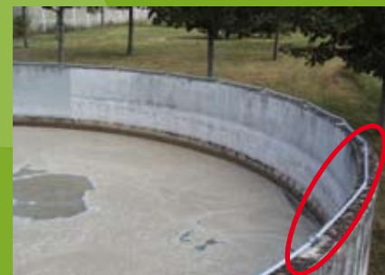
Bassin de décantation
